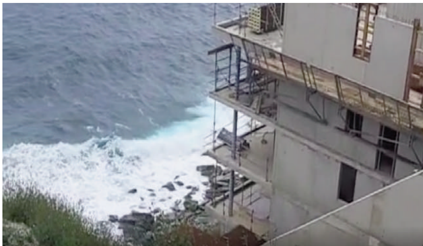
Chantier de construction de la promotion Pietramare à Petranera, commune de San Martinu Di Lotta
